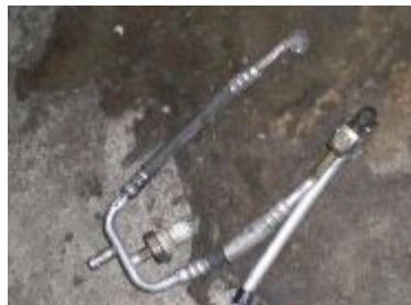
Drossel (metallische Verdickungsstelle rechts), Doppeldruckschalter und Befüllungsanschluss
