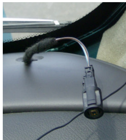
Sonnensensor, beim Einbau
